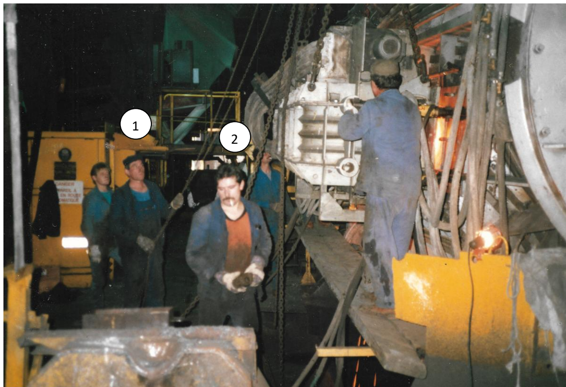
Photo N°26: 1989 Four 56 tonnes Inducteur en cours de démontage
